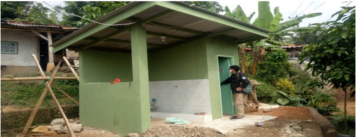
Gambar 1. Keterangan : Pembangunan MCK di Dusun Haraan Kampung Dalam Kecamatan Bilah Hulu
